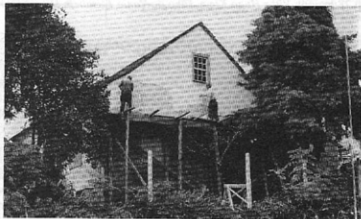
Substituição do reboco na casa da Av. São Miguel, 1961, em Dois Irmãos.
